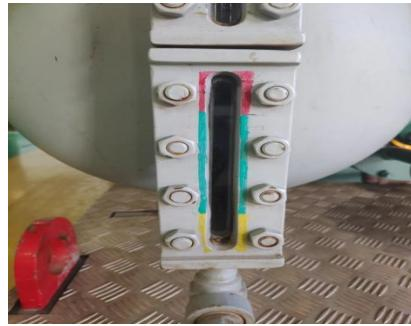
2、检查油分离器油位视镜油位需高于上视镜 2/3 高度且回油器，油离器三段视镜无油。
