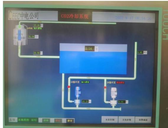
5、无异常，选择模式 1 按下启动键启动机组，同时确认冷端上位机 CP14 主制冷机处于“在线”状态。
