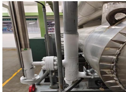
7、机组运行 30 分钟后观察工艺罐内不补液状态下工艺罐内压力保持在 2650Kpa 左右，机组吸口温度在 3℃左右，过热度在
