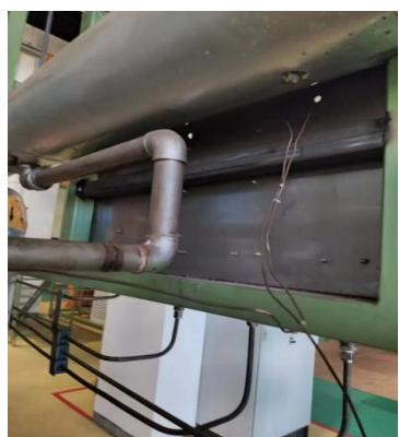
2、CP09\CP11 在固定支架不锈钢板线孔处加装圆形橡胶保护套对检测线进行保护；
